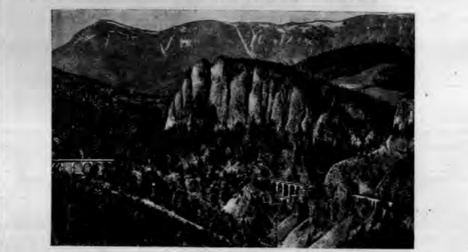
Linia kolejowa na Semmeringu, z jej wiaduktami i tunełami. W tem miejscu wykonano zamach bombowy, który uszkodził tunel i tor, wskutek czego ruch jest narazie przerwany. Zamach ten, to tylko jedno ogniwo w łańcuchu dzieł zniszczenia zamachów, wykonanych w Austrii w ciągu 24 godzin przez grupy terrorystyczne
