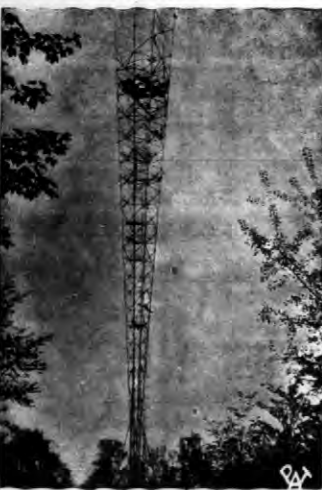
Widok obecnego w budowie masztu radiostacji toruńskiej. Widać 140 metrów wysokości i różni się od innych tego rodzaju masztów oryginalną formą konstrukcji. Sama radiostacja będzie urządzeniem jedynym w naszym kraju.
