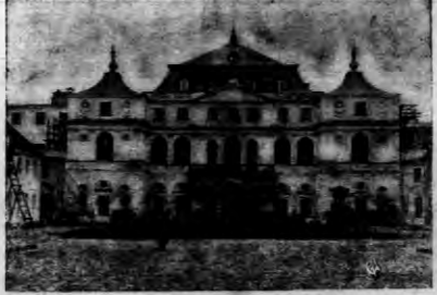
Facada gmachu Ministerstwa Spraw Zagranicznych (Pałacu Brihla) przy placu Józefa Piłsudskiego, po rekonstrukcji dokonanej według projektu arch. Bohdana Pniowskiego.
