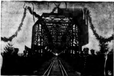
Ogólny widok nowowybudowanego mostu na rzece Horyń, koło Antonówki na linii kolejowej Szary - Kowel. Otwarcie mostu nastąpiło dnia 2 k. m.
