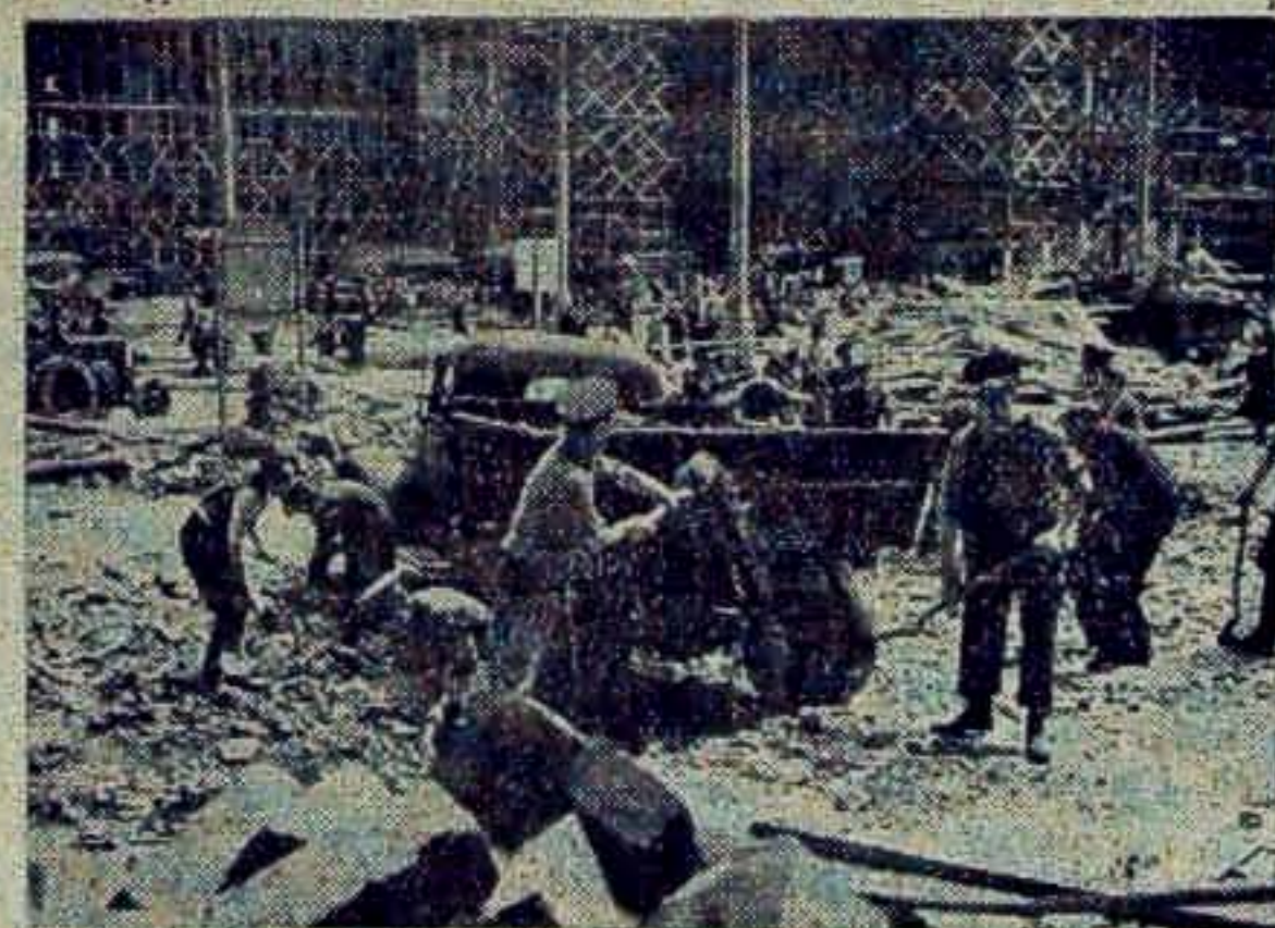
Żołnierze i oficerowie WP pomagają budowniczym Marszałkowskiej Dzielnicy Mieszkaniowej w Warszawie. CAF — fot. Nowosielski
