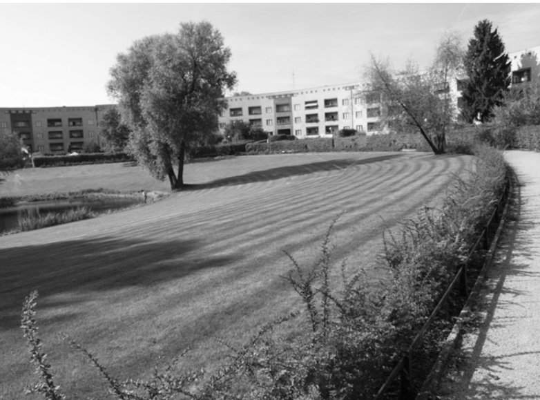
Ryc. 3. Owalny dziedziniec wewnątrz budynku-podkowy; fot. W. Niebrzydowski
