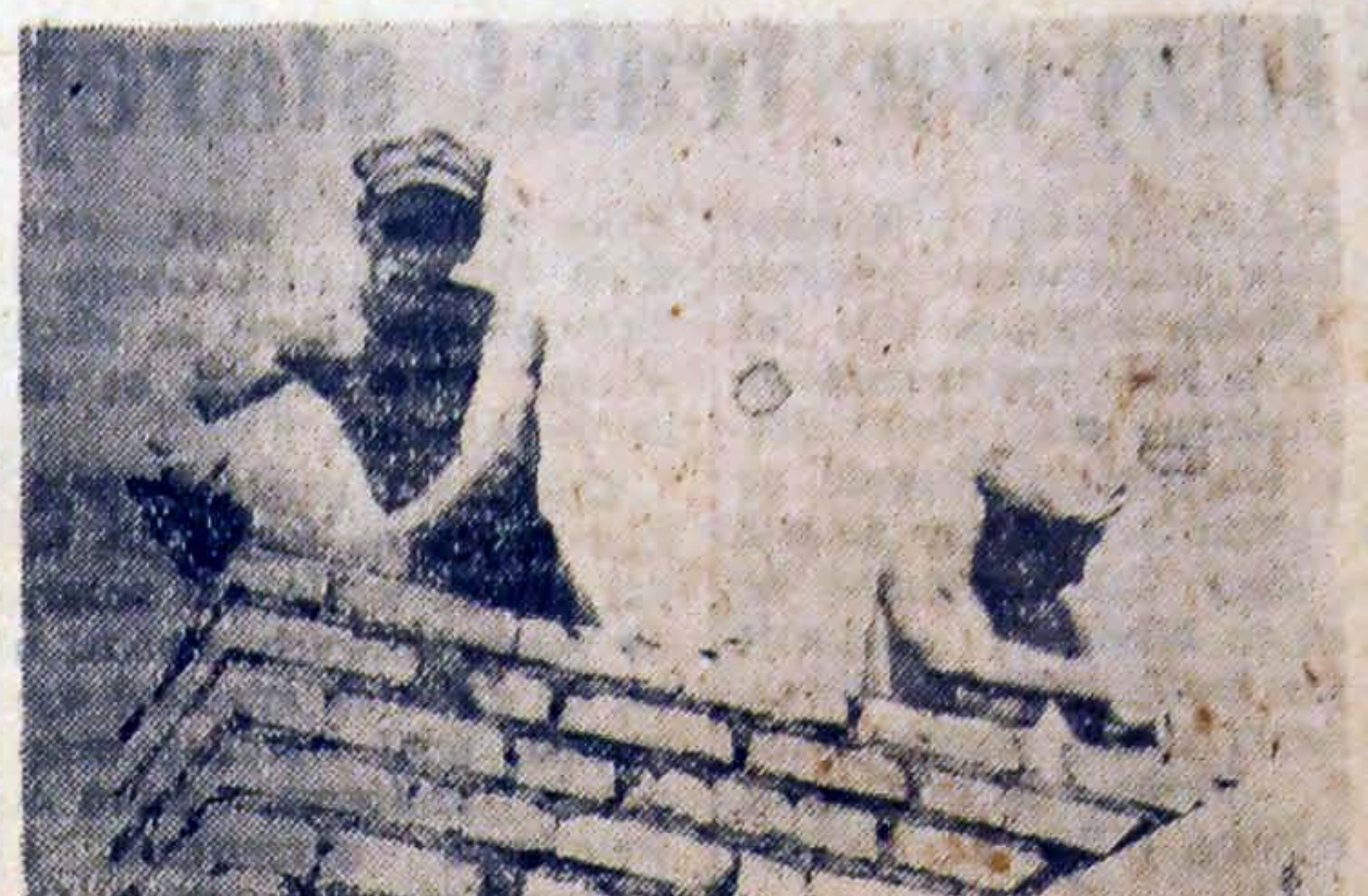
Mimo upalnych sierpniowych dni białostocki murarz stale walczy o przekroczenie norm produkcyjnych. Na budowie ZOR Nr 31 murarze Józef Krysko i Antoni Borowicz (na zdjęciu) wykonują średnio 136 proc. normy.
