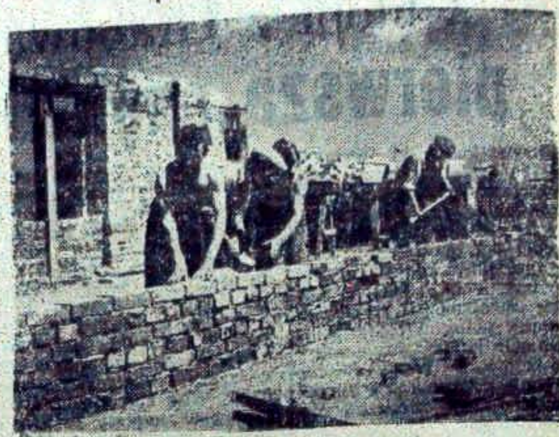
Dla uczczenia święta 22 Lipca brygada Antoniego Badocha ukończyła się wykonać 260 m sześciu muru ponad plan. Na zdjęciu „Piątkowy” murarski przy murowaniu jednego z bloków mieszkalnych. CAF — fot. Ostrowski Jerzy
