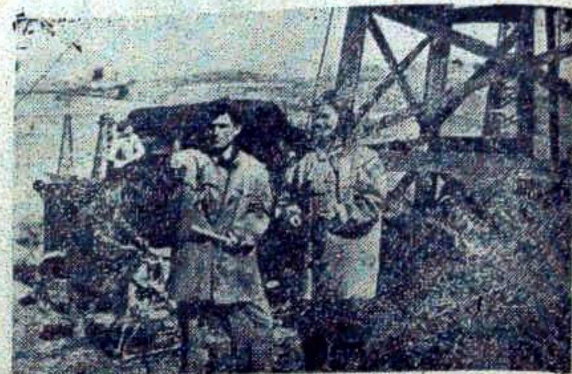
Jednym z pierwszych nowopowstałych obiektów pięcioletniego planu jest budowa potężnej rafinerii ropy naftowej „Stalin”. Jak przewiduje uchwała rządu, budowa rafinerii zostanie zakończona w 1954 roku. — W pobliżu rafinerii powstanie nowoczesne osiedle robotnicze.
