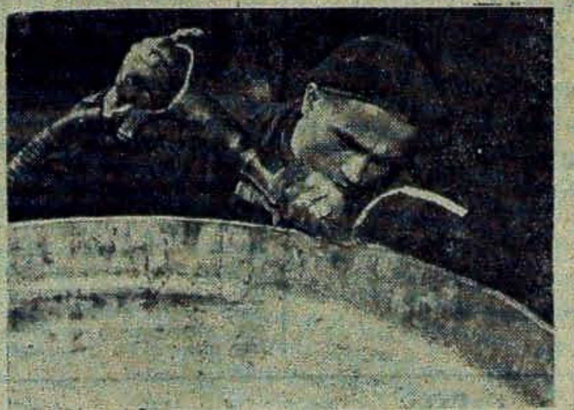
Zakłady Azotowe im. F. Dzierżyńskiego stale zwiększają produkcję nawozów sztucznych. Na zdjęciu: Przetwarzający siłazę Franciszek Szczupak dopasowuje dno do zbiornika kwasu azotowego. CAF — fot. Baranowski.
