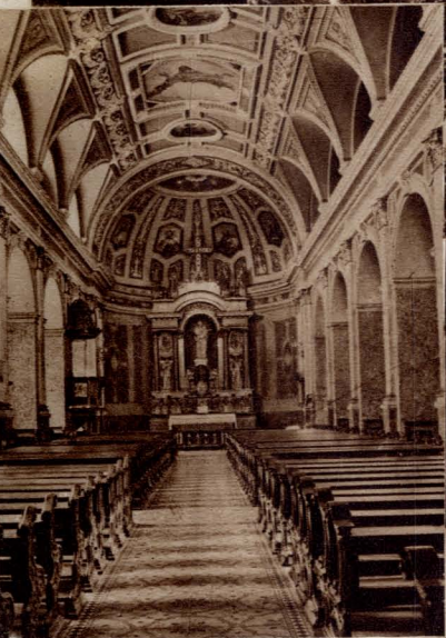
Po lewej: Wnętrze kaplicy
