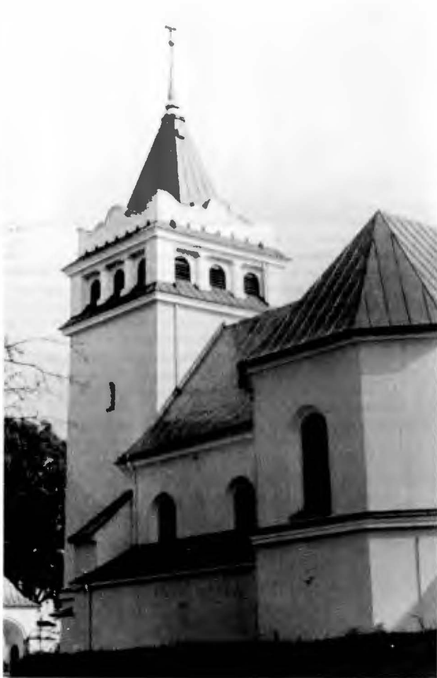
Łapy, Kościół Parafialny pw. ŚŚ Piotra i Pawła. Widok elewacji bocznej Fot. A. Dolistowski, 1995 r.
