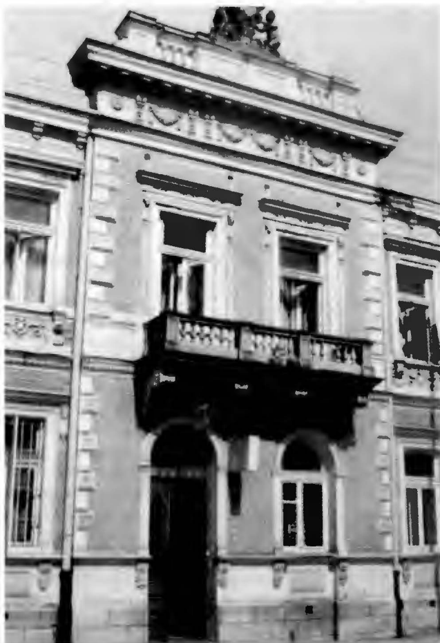
Pałac Tyllingów, fasada ryzalit środkowy fot. A. Dolistowski 1997.
