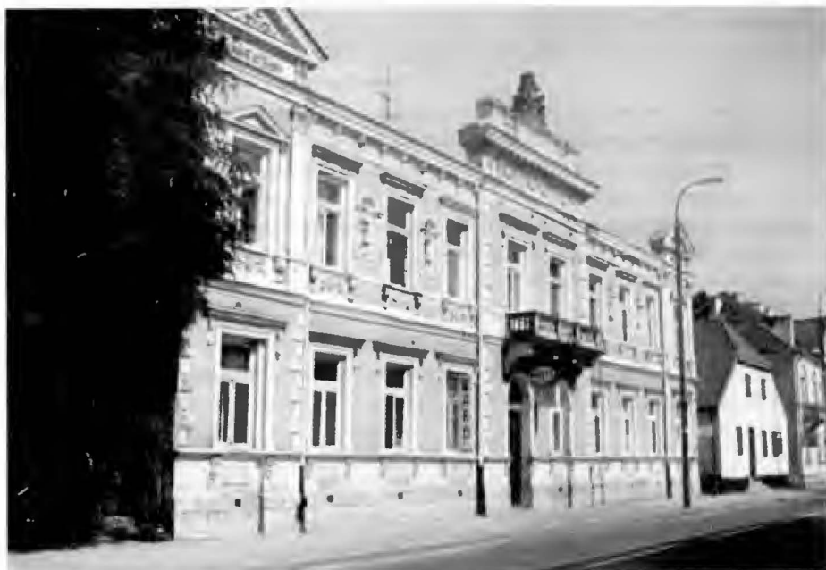
Pałac Tryllingów, elewacja frontowa fot. A. Dolistowski 1997.
