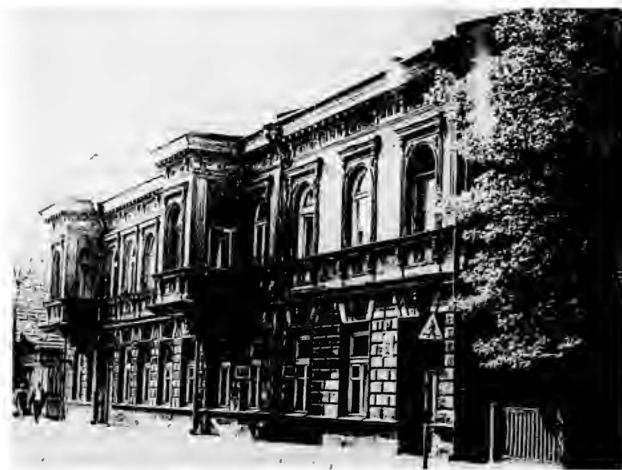
Il. 1 Elewacja frontowa kamienicy przy ul. Warszawskiej 50. Fot K. Janikowski, 1990 r.
