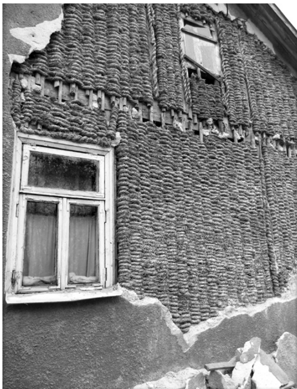
Ryc. 11. Dom nr 75 we wsi Olendy, z widoczną strychulcową konstrukcją ścian; fot. A. Biernacka i N. Garwołńska
