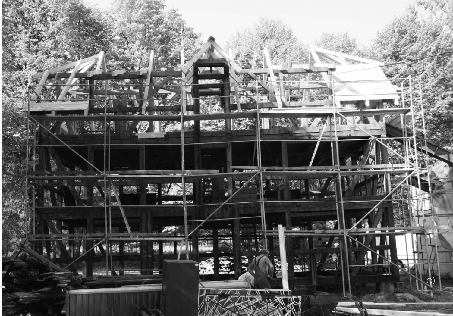
Ryc. 4b. Magazyn szyszek w Czarnej Białostockiej.; prace remontowe, widoczny układ konstrukcyjny; fot. autor, maj 2013 r.
