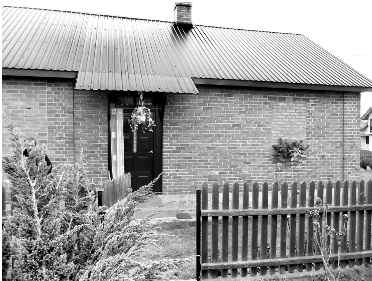
Ryc. 13. Dom nr 86 we wsi Olendy, o ścianach strychulcowych obłożonych cegłą; fot. A. Biernacka i N. Garwolińska
