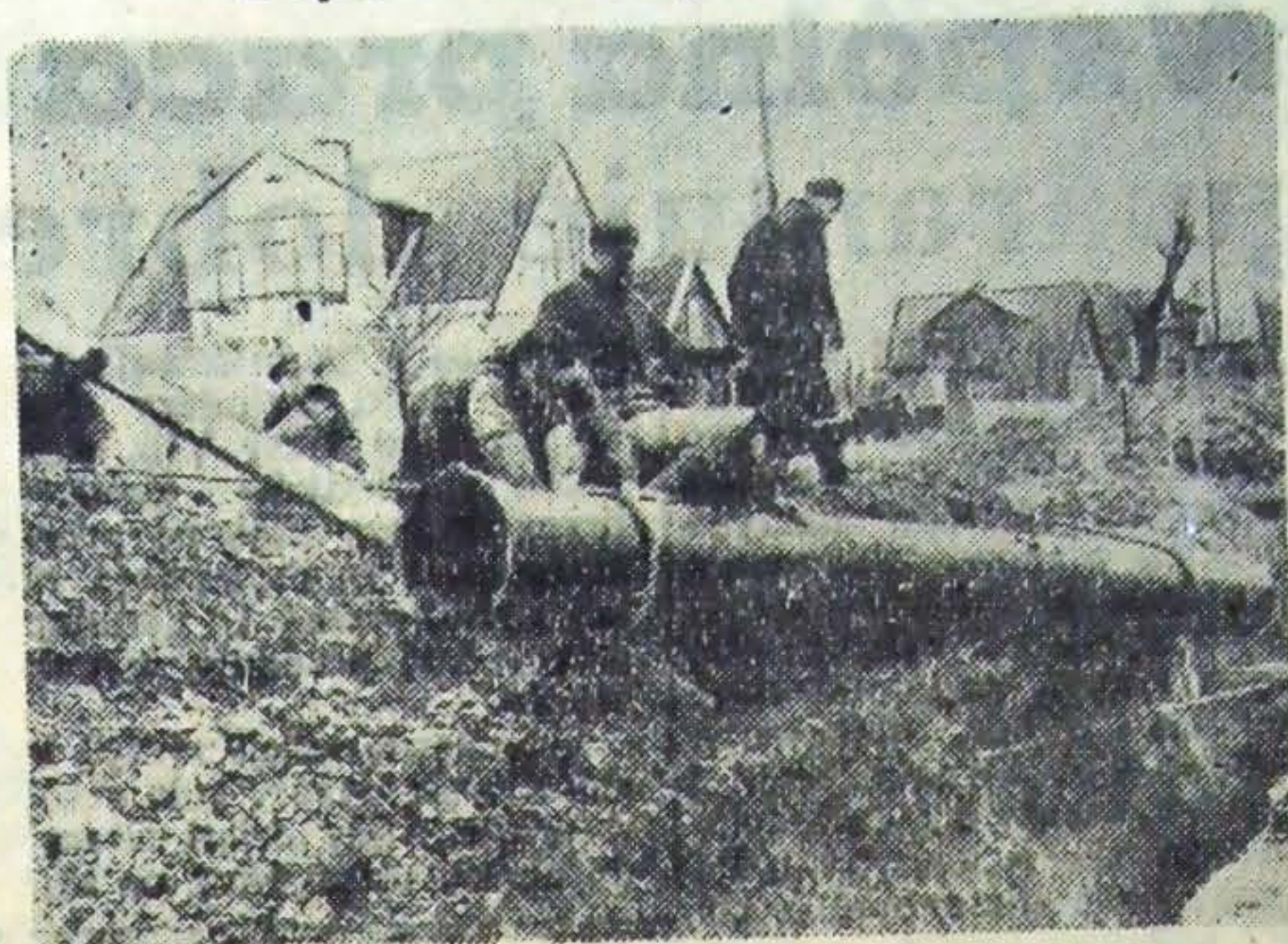
Taka rurka, jaką widzicie na zdjęciu, waży nie mniej niż wiecie tylko półtorej tony. Właśnie z takich rurek buduje się nowy rurociąg z Wasilkowa do Białegostoku. Rurociąg ten ośmiokrotnie zwiększy dopływ wody dla miasta. Na zdjęciu: uczniowie pomagają robotnikom w zakładaniu nowego rurociągu.
