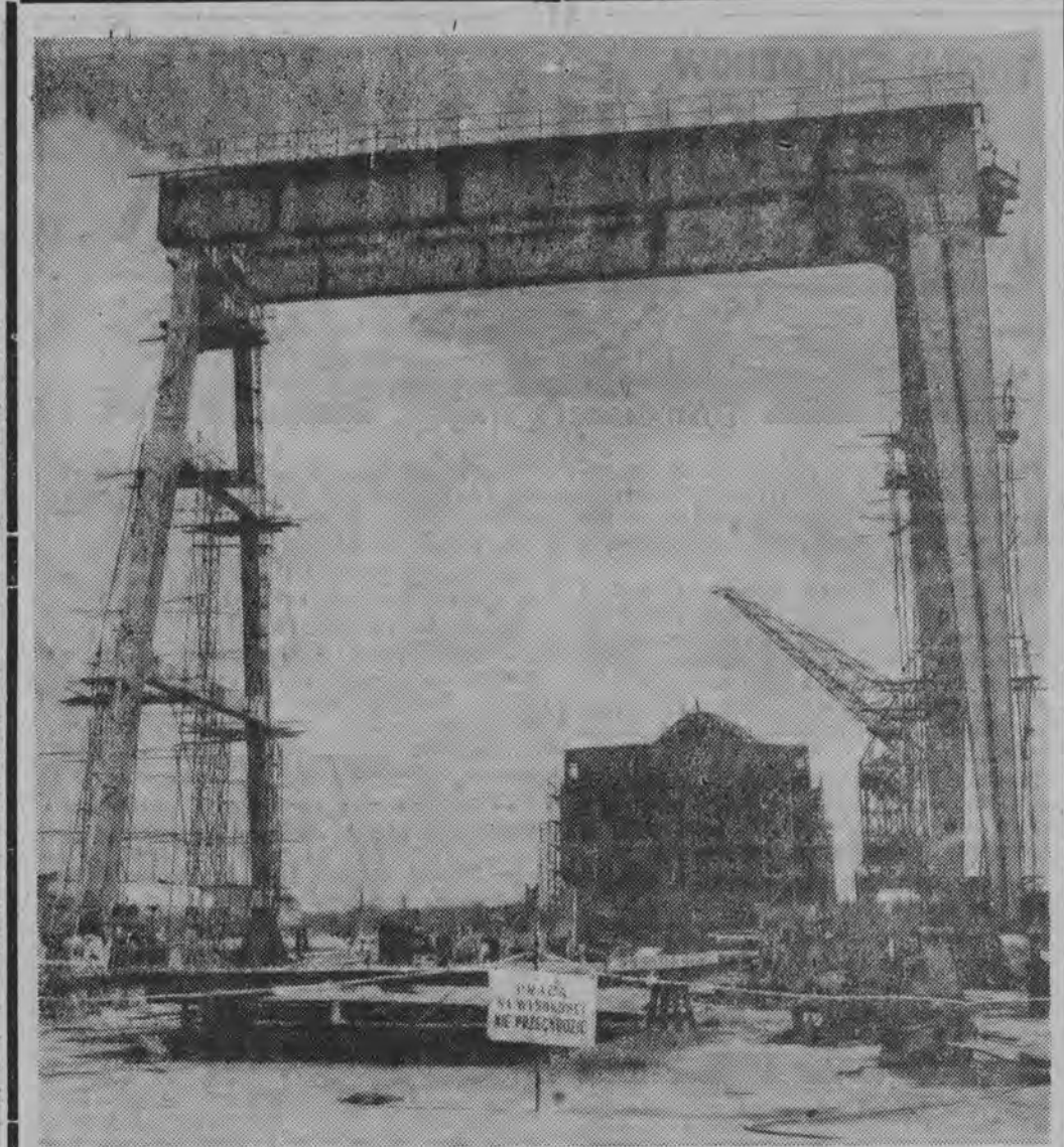
Port szczeciński obok Gdańska i Gdyni jest naszym najwęższym oknem na świat. Nigdy dotąd nie był on tak wykorzystany jak obecnie. W Stoczni Szczecińskiej im. Adolfa Warskiego trwają prace przy montażu dwu wielkich dźwigów bramowych każdy o udźwigu 100 ton. Fot. — CAF
