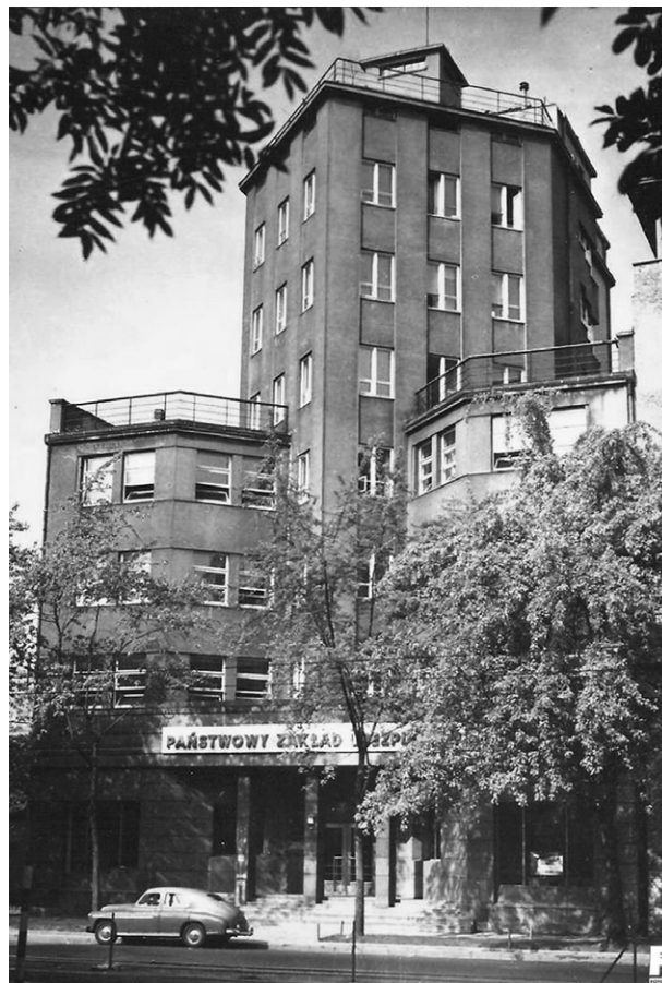
Ryc. 17. Gmach Powszechnego Zakładu Ubezpieczeń Wzajemnych zaprojektowany przez Wacława Rytla, Łódź 1929-1932; źródło: http://lodz.fotopolska.eu/126426,foto.html
