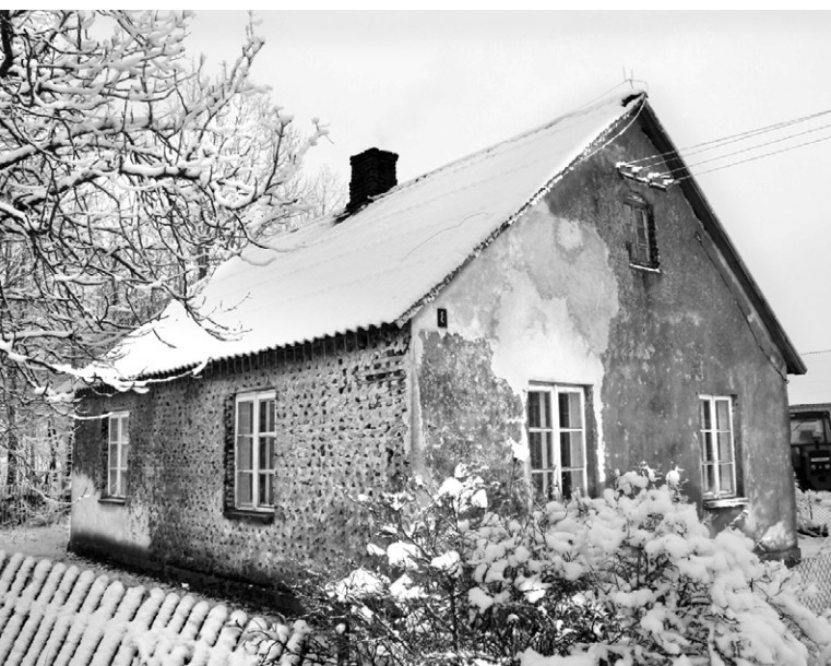
Ryc. 1. Budynek mieszkalny we wsi Drewnowo-Gołyń; fot. A. Sołowińska, 2014
