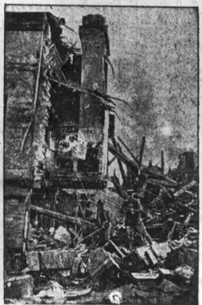
Ruiny domów w Montauban.
