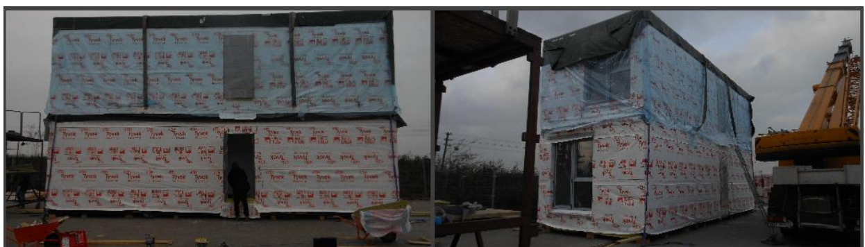
Rys. 9. Ustawienie modułów podczas badania izolacyjności akustycznej stropu I
