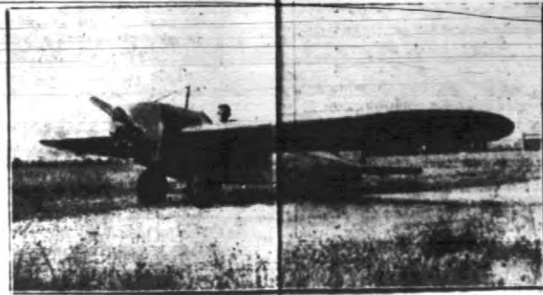
Niemcy przystępują do budowy i sprzedaży samolotów, kosztujących tylko po 950 mk., t. j. nieco ponad 2.000 zł. Samoloty wyposażone są w motory o sile 14 koni mechanicznych i osiągnęły szybkość przeciętną 90 km. na godzinę.
