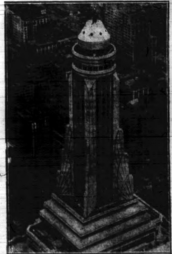
Na wysokości 425 m. na szczyt najwyższego nowojorskiego budynku t. zw. „Empire State Building” ustawiono maszt ćwiczeń dla małych sterowców.
