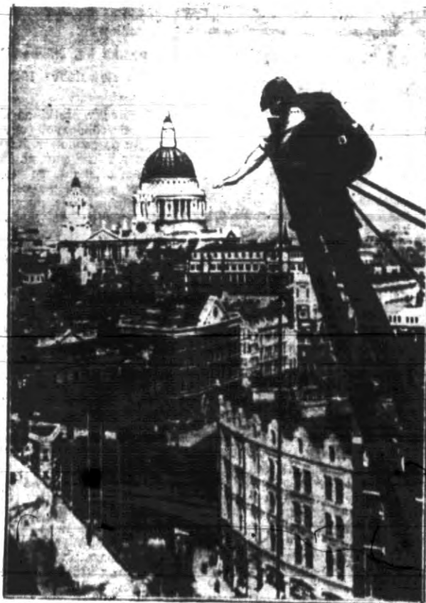
Robotnik pracujący na rusztowaniu jednego z londyńskich drapaczy chmur, zawieszony nad 50 metrową przepaścią.
