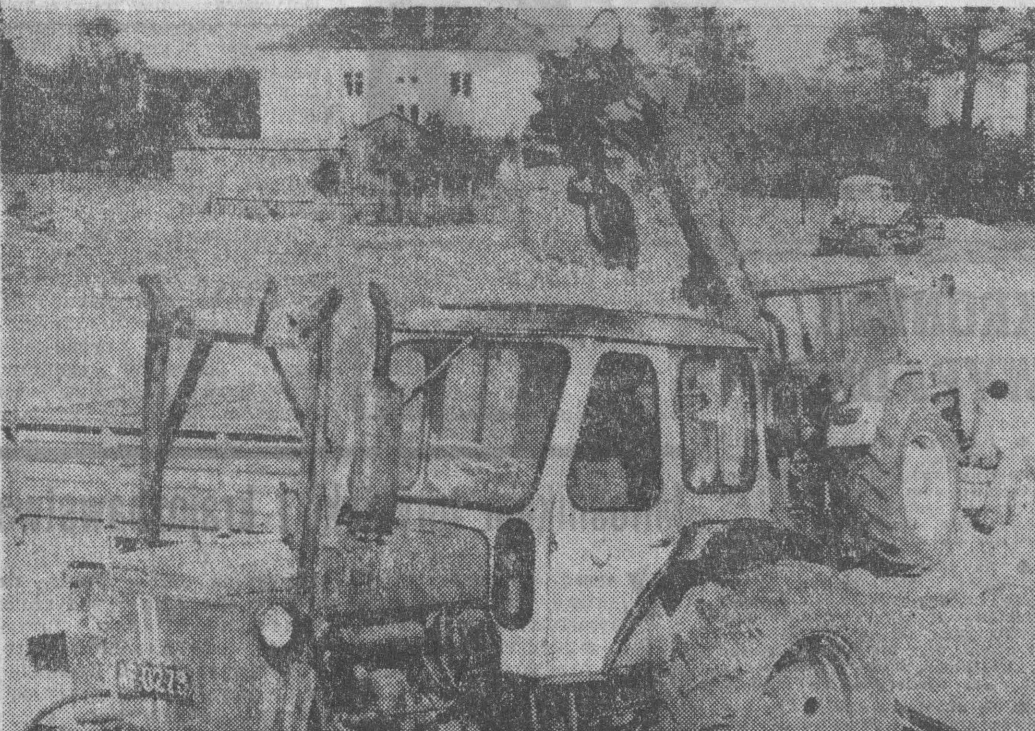
Na budowie stadionu leśnego.
