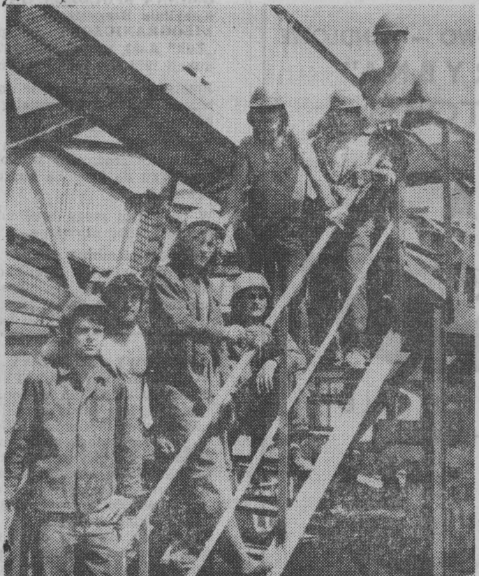
Brygada Henryka Pośpiecha z plockiego „Mostostalu”. To ona wyznacza tempo montażu urządzeń technologicznych zakładu w Sobolewie.
