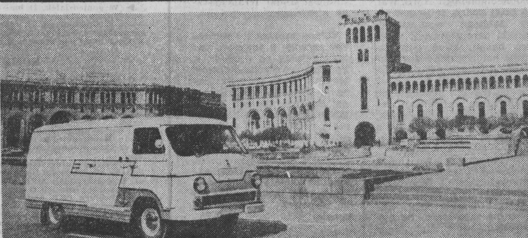
Prototyp dostawczego samochodu elektrycznego, zaprezentowanego przez Laboratorium Instytutu Politechnicznego im. Karola Marksa w Erewaniu (Armieńska SRR), rozwija szybkość do 66 km/godz., a na terenie podgórkim — 45-46 km/godz., przy obciążeniu 500-600 kg. Źródłem energii elektrycznej jest generator połączony z zestawem akumulatorów. CAF — TASS
