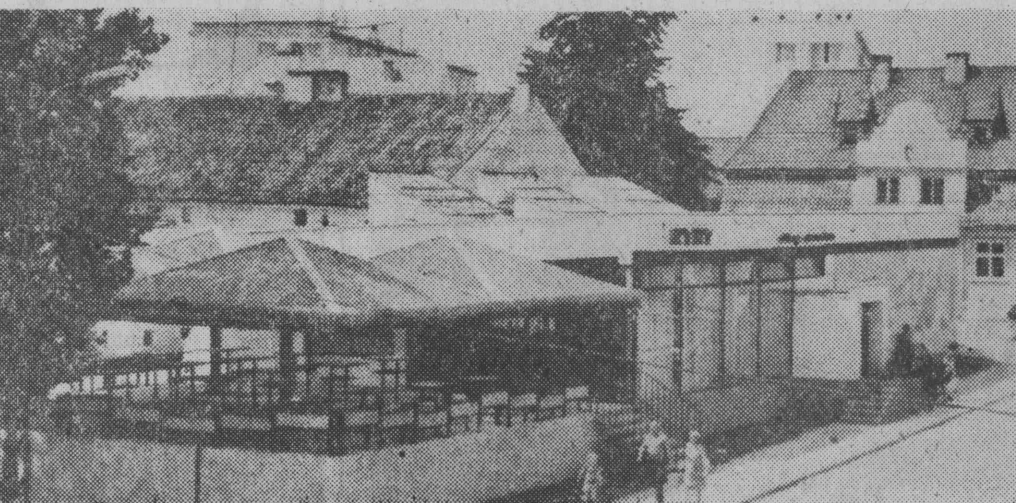
Pawilon Centrali Rybnej (sklep, smażalnia) w Pisz, wybudowany przez Komunalne Przedsiębiorstwo Remontowo-Budowlane.
