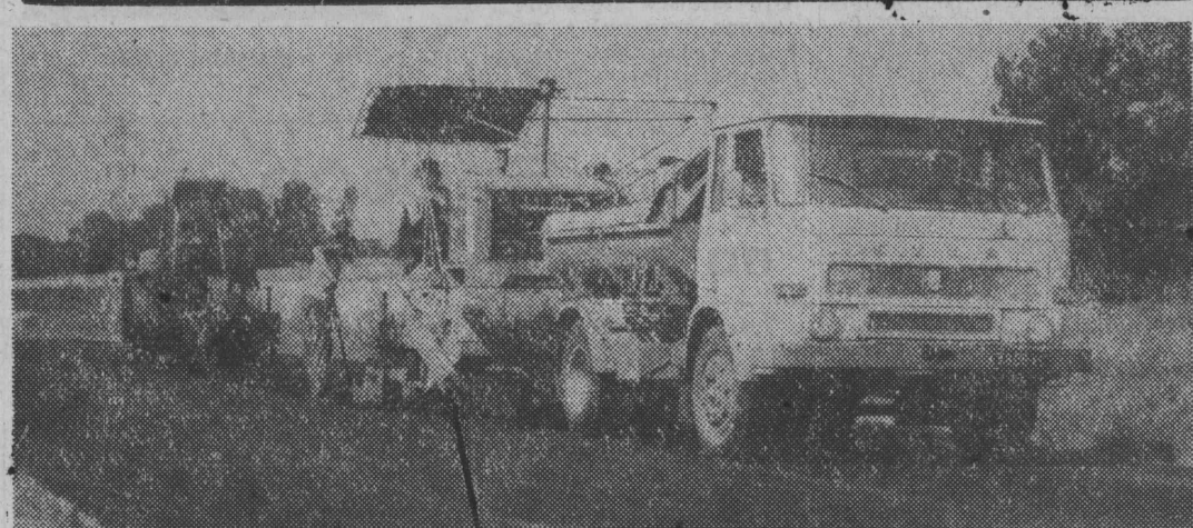
Na terenie wielu województw trwa obecnie prace mające na celu modernizację dróg. NA ZDJĘCIU: pracownicy Rejonu Eksploatacji Dróg Publicznych w Łwówku Śląskim przy modernizacji jednej z tras. CAF — WOŁOSZCZUK
