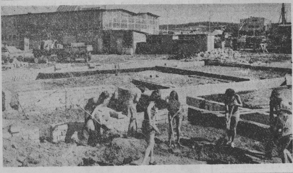
NA ZDJĘCIU: pracownicy Zakładów Stolarstwa Budowlanej w czynnie społecznej na budowie nowego przedszkola wykonują prace ziemne.
