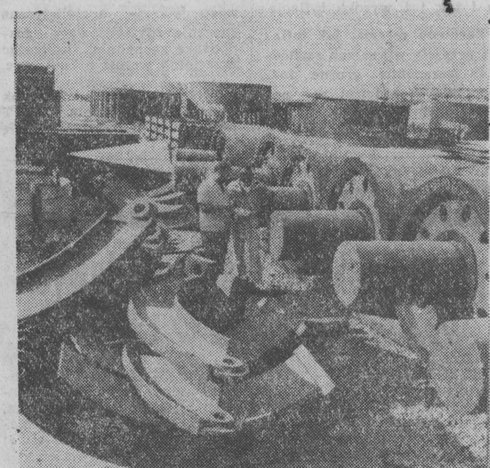
W Ożarnowie woj. tarnobrzelskiego, realizowana jest budowa jednej z największych cementowni w kraju. Inwestycja zakończona ma być za dwa lata. Zdolność produkcyjna ożarnowskiej cementowni będzie 2 mln 400 tys. ton cementu rocznie, otrzymanego metodą suchą, w pełni automatyzowaną — co stanowi takie nowość w skali krajowej. NA ZDJĘCIU: na budowie cementowni w Ożarnowie. CAF — Stan
