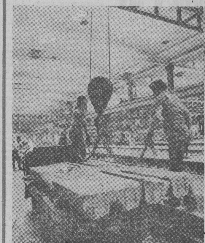
Roczna produkcja wytwórni podkładów struno-betonowych „Kolbet” w Suwałkach wystarcza na ułożenie linii kolejowej z Suwałk do Gdańska i pozwala na zaoszczędzenie stu hektarów lasu. Produkowane podkłady przystosowane są do szyn typu średniego i ciężkiego. Zakład przekazany do eksploatacji cztery lata temu wyposażono w krajowe urządzenia.
