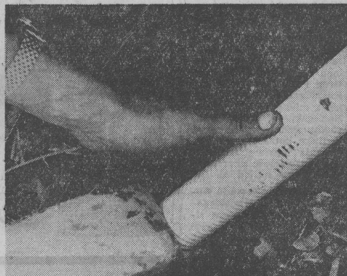
NA ZDJĘCIU: moment układania przez maszynę plastikowego drenu.
