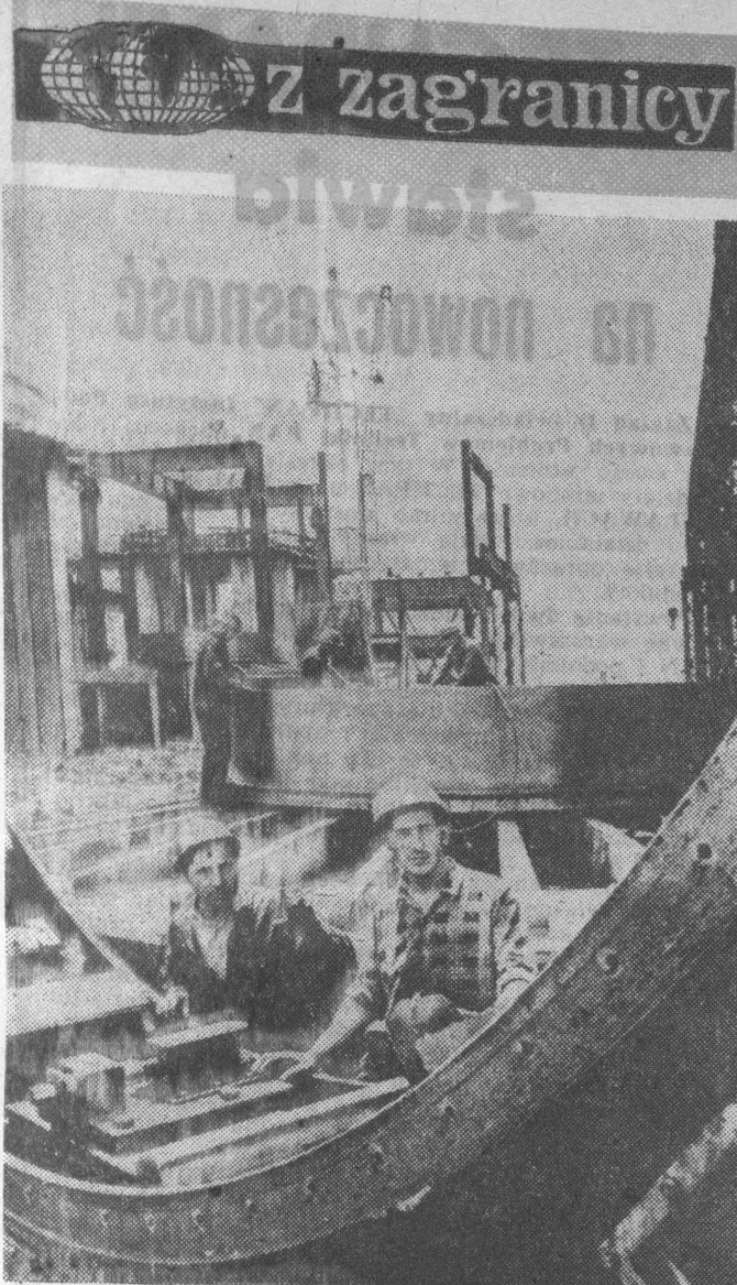
ZSRR. Nowospańska Fabryka Cementu w Kraju Nadmorskim jest jedną z ważniejszych inwestycji roku 1975. Budowniczym zobowiązali się pierwszy oddział przedsiębiorstwa oddać do eksploatacji jeszcze w IV kwartale tego roku. Po osiągnięciu pełnej mocy produkcyjnej fabryka dać będzie 1 milion 150 tysięcy ton cementu rocznie.
