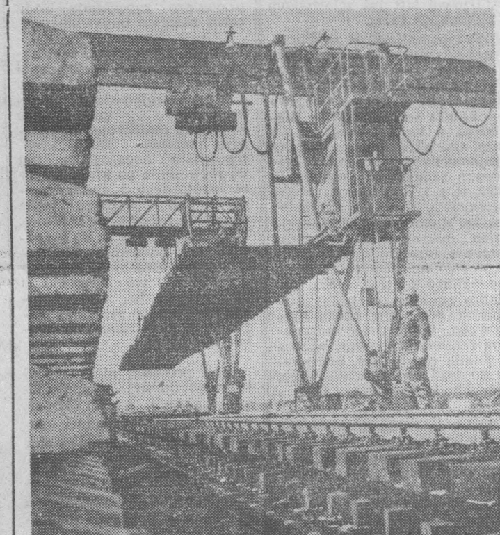
Budowa linii kolejowej.
