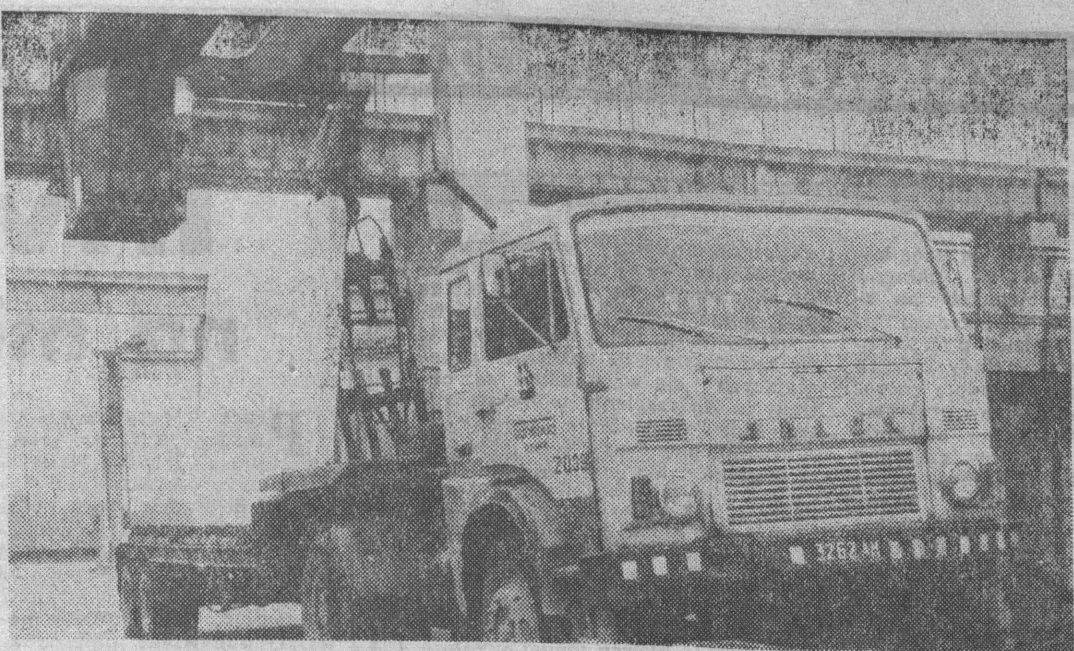
Wielkie elementy budowlane wędrują na ciężarówce.
