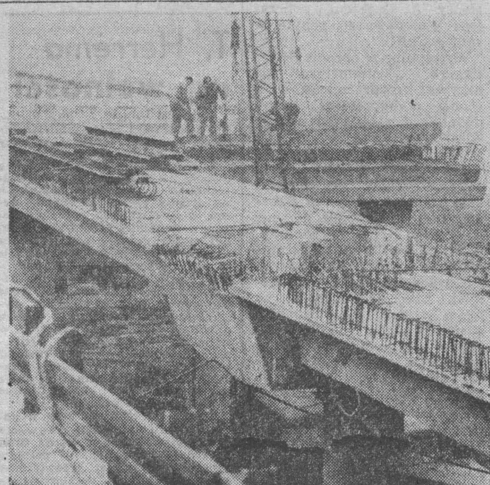
Budowa warszawskiej Estakady Nieleśkiej osiągnęła już fazę końcową. Żołaga Północnego Przedsiębiorstwa Robot Drogowych planuje zakończenie pracy na terenie tej ważnej arterii komunikacyjnej przed VII Zjazdem PZPR. Już za kilka dni zakończone zostaną roboty drogowe na jezdnii zachodniej, gdzie aktualnie trwa montaż barier ochronnych, zakładanie instalacji oświetleniowych i asfaltowanie. Na jezdnii wschodniej dobiega koniec prac konstrukcyjnych, trójczajne i betoniarstwo. Natomiast na brzegu Wisły Hydrobudowa nr 6 prowadzi roboty regulacyjne.
