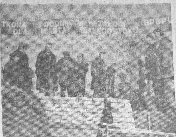
NA ZDJĘCIU: wmurowanie aktu erekcyjnego pod budowę złobka przy ul. Narwskiej w Białymstoku. Fot. A. Sokółski
