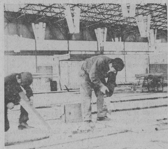
NA ZDJĘCIU: (od lewej) ślusarz Stanisław Żukowski i stolarz Jerzy Kirej przygotowują elementy do wykładania ścian wewnętrznych pawilonu handlowego przy ul. 1000-lecia Państwa Polskiego.
