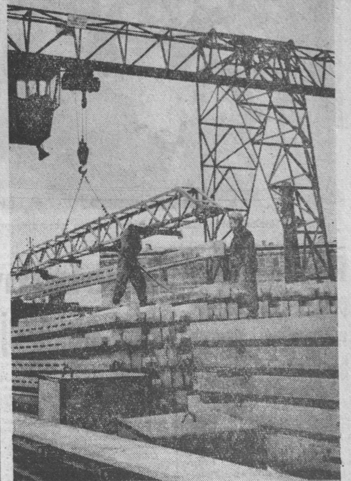
W minionym pięcioleciu dynamicznie rozwijała się budownictwo. Oddano m. in. do użytku 61 fabryk domów i wytwórni wielkopłytowych.
