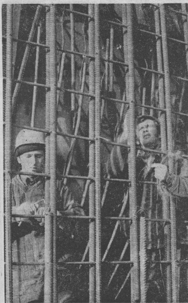
NA ZDJĘCIU: Ryszard Maciejczyk i Antoni Wór przy zbrojeniu rur.
