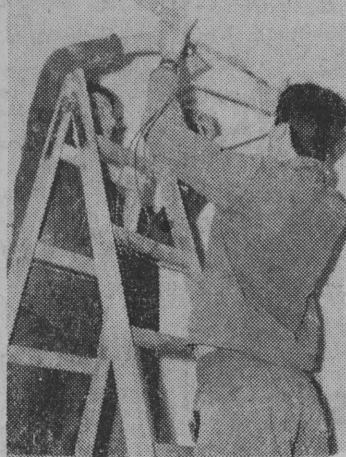
W budynku warsztatowym uczniowie Technikum Elektrycznego wykonują instalację elektryczną.
