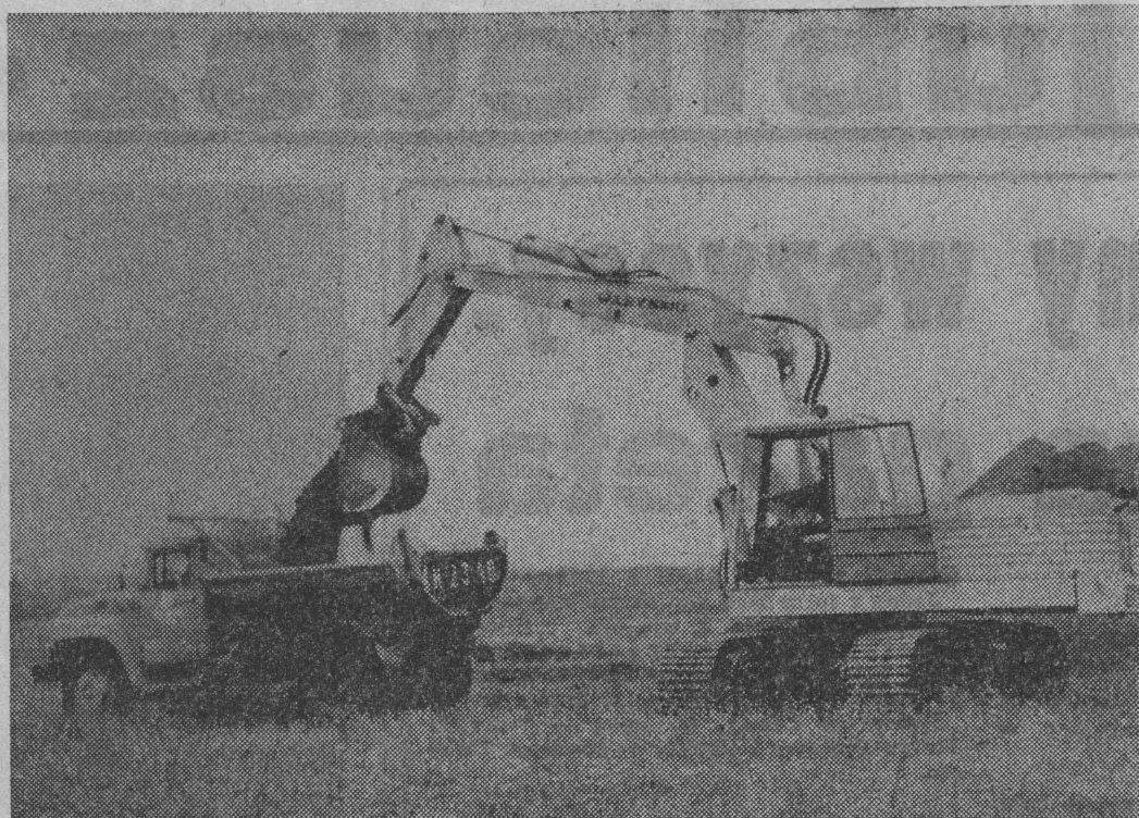
Przemieszczenie 57 tys. m sześć, ziemi to preludium właściwej budowy.
