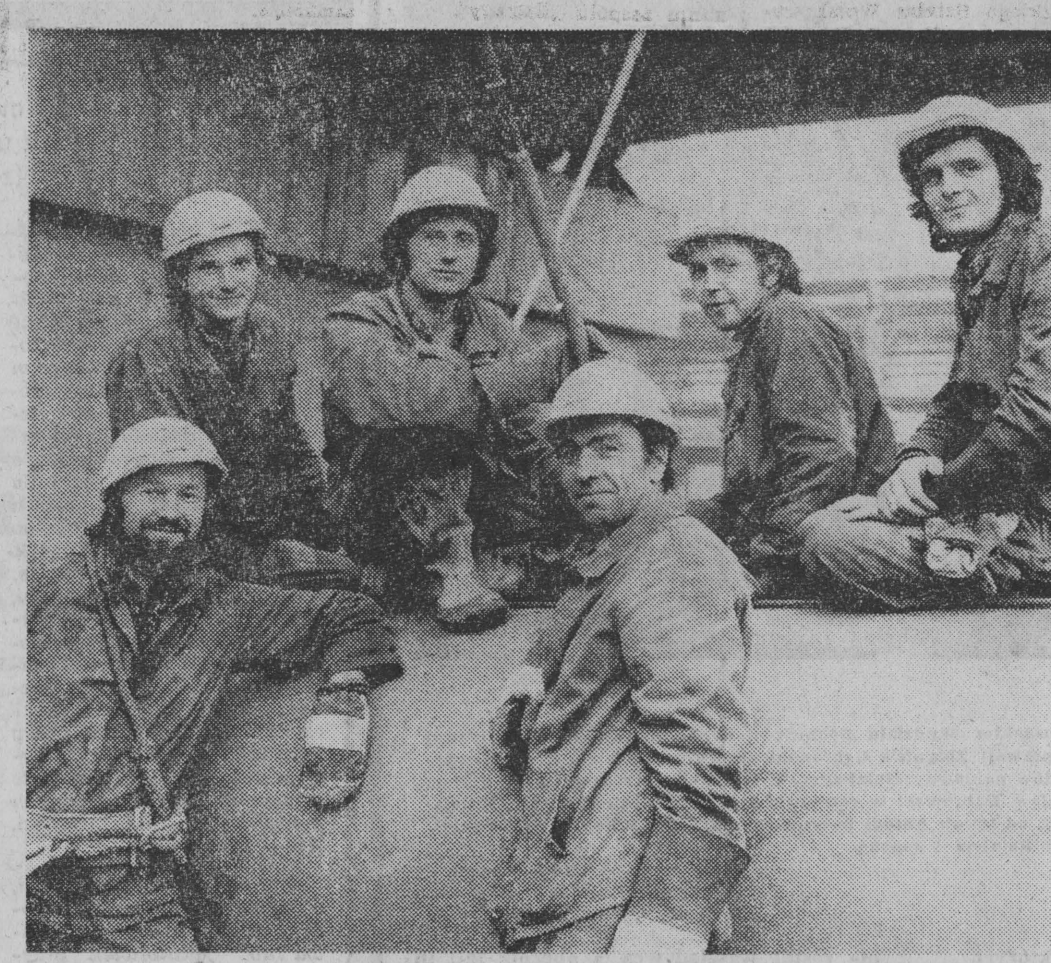
NA ZDJĘCIU: grupa pracowników „Instalu” na budowie Huty Katowice. Zdjęcie Z. Wierzeń
