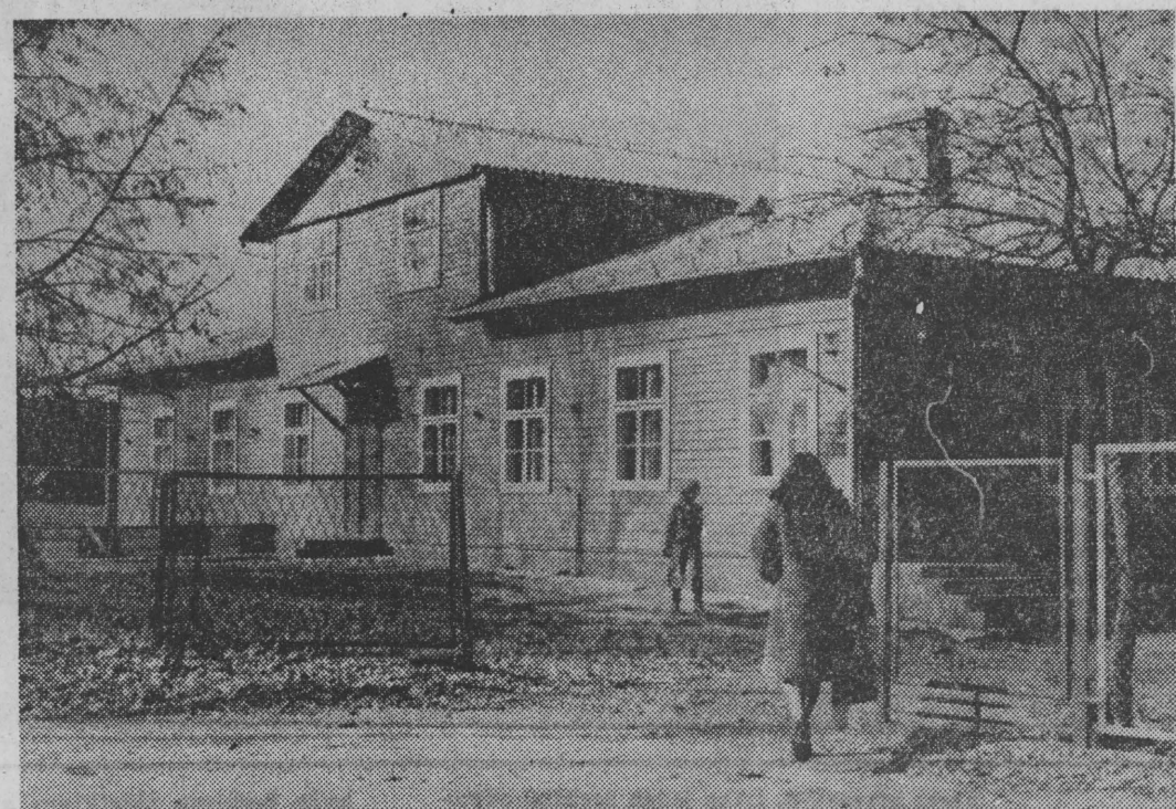
Ten oto, dawny budynek szkoły, zaadaptowano na potrzeby ośrodka kultury. Fot. ZDZISŁAW ZAREMBA
