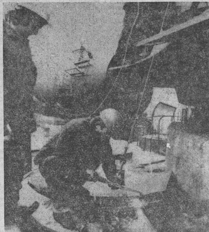
Trwają prace przy budowie elektrowni szczytowo-pompowej w Żarnowcu, woj. gdańskie. Obecnie prowadzone są m. in. roboty w dole fundamentowym siłowni „Enerpopol” Północ montujące spirale na blokach 3 i 4 turbiny. Rozpoczął się również montaż rurociągów na wejściu do tych turbin. CAF — Ukłejewski — telefoto
