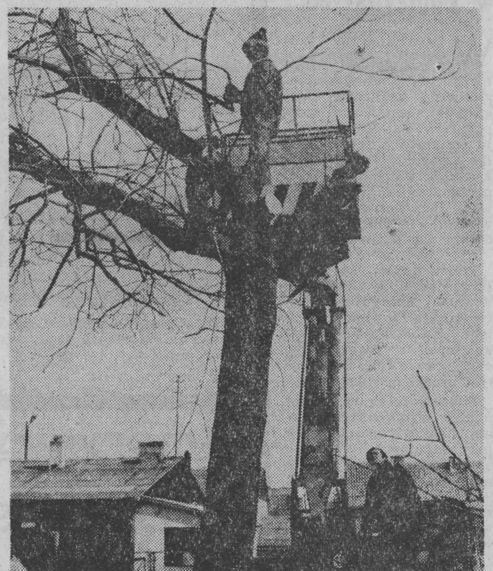
Pracownicy Zakładu Energetycznego w Elku obcinają nadmierne rozroście gałęzie drzew. Podczas dużego wiatru były one przyczyną częstej awarii sieci elektrycznej. Fot. Z. Zaremba
