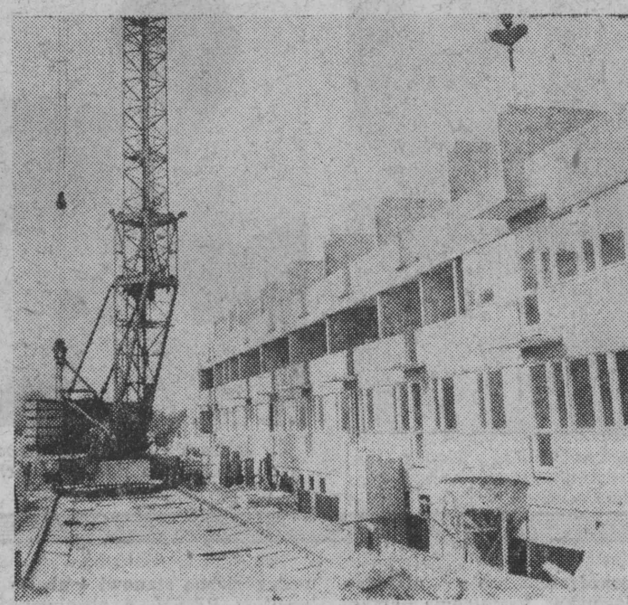
NA ZDJĘCIU: następny budynek mieszkalny w budowie. Fot. Gabor Lochny
