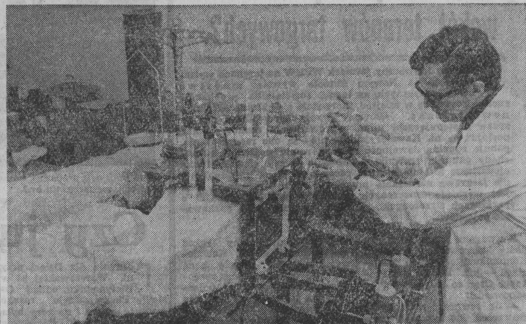
NA ZDJĘCIU: mgr JAN DUDZIŃSKI z Katedry Ekonomiki i Organizacji Drzewnictwa Instytutu Mechanizacji i Technologii Drzewa przy pomiarze naprężeń desorpcyjnych podczas suszenia drewna.
