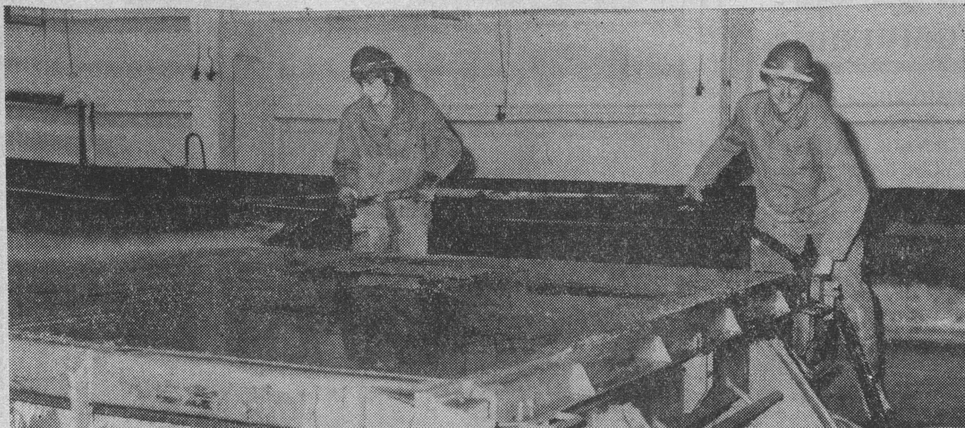
Pierwsze, eksperymentalne płyty zewnętrzne do klatek schodowych, poddawane są właśnie „zabiegom kosmetycznym”. Witold Sniatkowski (od lewej) i Stanisław Szostak spukują fakturę jednego z elementów.
