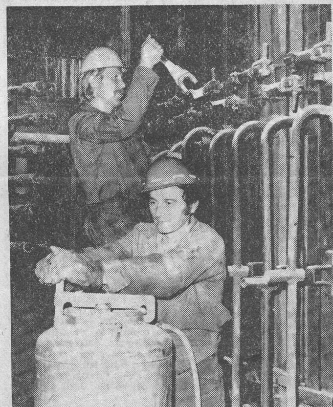
Trwają ostatnie przygotowania do rozruchu ciągu technologicznego. Tadeusz Buca (na zdjęciu wyżej) i Andrzej Stefanowicz sprawdzają śruby, spinające tzw. kasetę.
