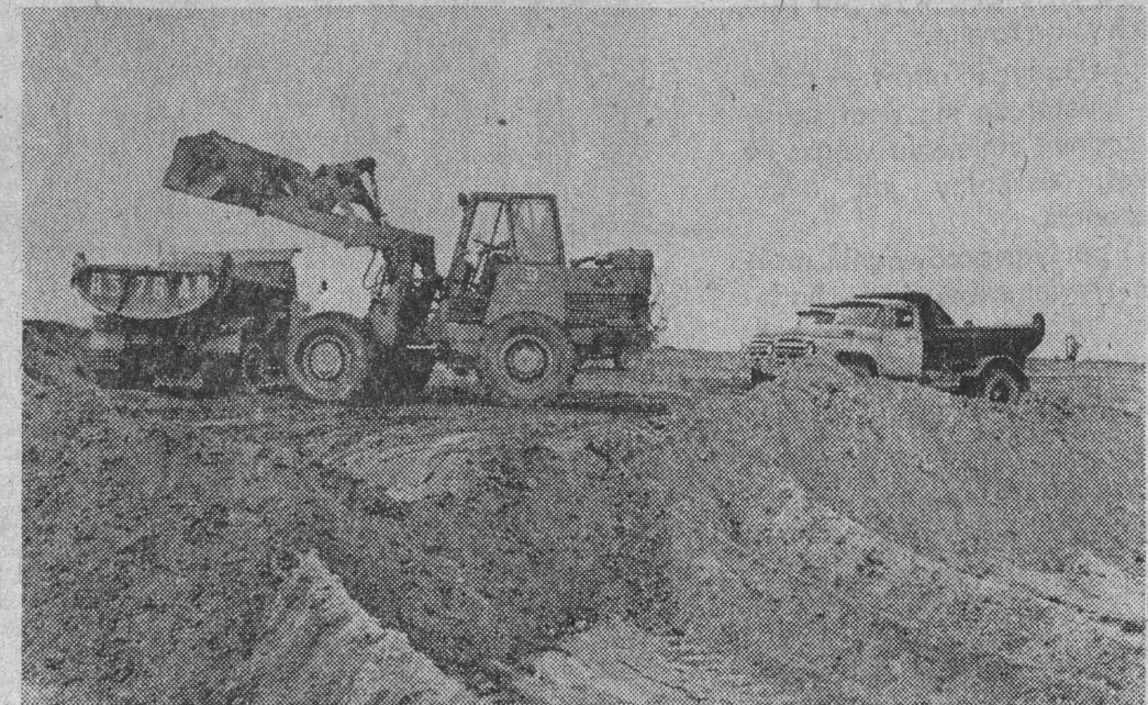
NA ZDJĘCIU: na placu budowy roboty ziemne idą pełną parą.
