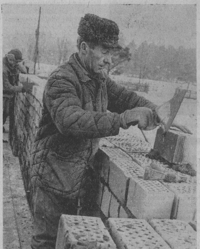
Trwa wznoszenie budynku socjalnego. Wśród murarzy pracuje Jan Gotowski. Fot. Zdzisław Lenkiewicz
