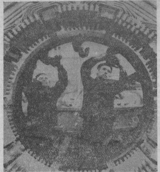
Wrocławski „DOLMEL” w tym roku wyprodukuje jeden turbopomp dla elektrowni „Jaworzno”, dwa — o mocy 210 MW dla Turcji oraz dwa generatory o mocy 63 MW dla elektrowni w Gdańsku i Białymostku. Do końca roku „DOLMEL” wyprodukuje podzespoły do montażu turbogeneratora 360 MW. Będzie to pierwsze urządzenie energetyczne o tak dużej mocy, wyprodukowane w kraju. CAF — Włoczek — telefot
