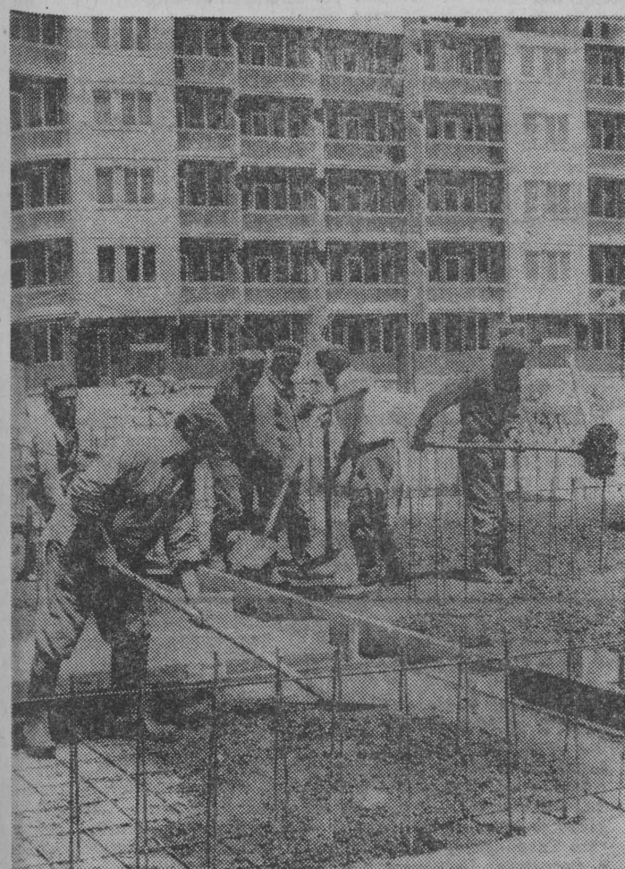
Na budowie nowego osiedla mieszkaniowego w Nagyka-nizsa.
