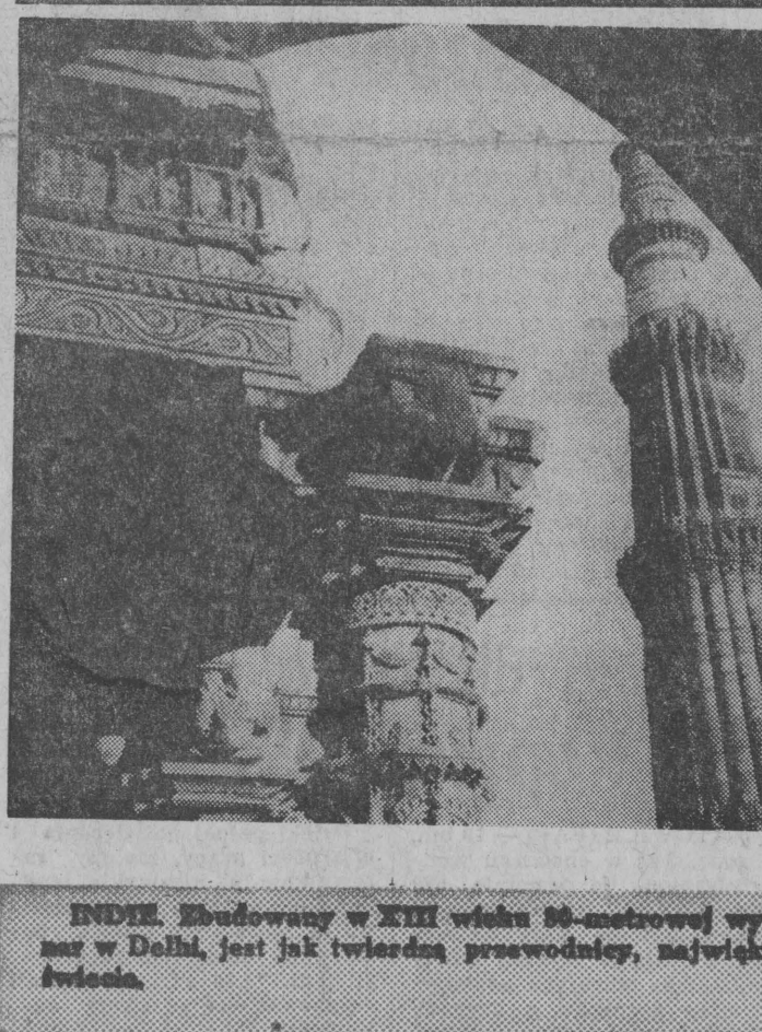
INDIE. Budowany w XIII wieku 80-metrowej wysokości minaret Kutub Minar w Delhi, jest jak twierdza przewodnicy, największą wolno stojącą wieżą na świecie.
