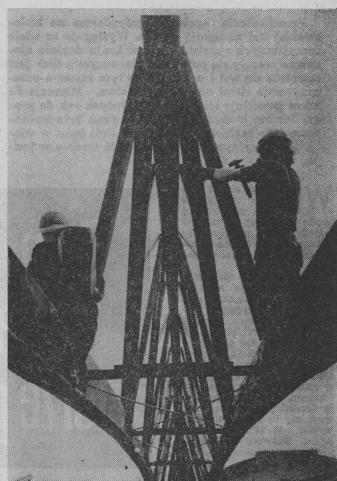
Konstrukcje stalowe z KZKSUD w Starostełach spotyka- ne są m. in. na tak ważnych dla kraju budowach jak Trasa Nadodrzańską, Centralna Magistrala Kolejowa oraz Linia Hutniczo-Słarkowa Hrubieszów — Huta Katowice. Fot. Z. Zaremba
